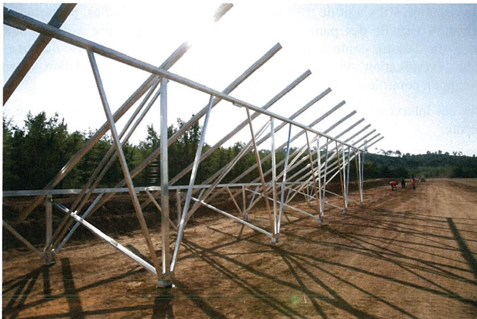
(photo : Krinner France ; montage des structures supportant les modules)
